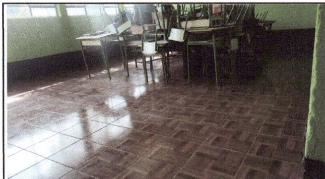
Foto 3: piso cerámico instalado en el aula No.3 del módulo 1.
