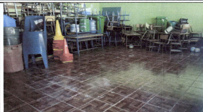
Foto 8: piso ceramico instalado en el aula No.3 del módulo 2.
