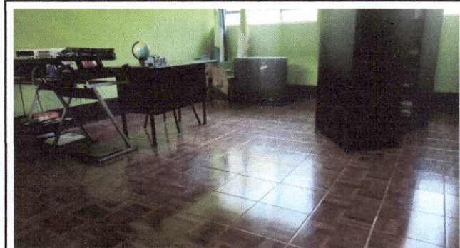
Foto 5: piso cerámico instalado en el anexo de dirección del módulo 1.
