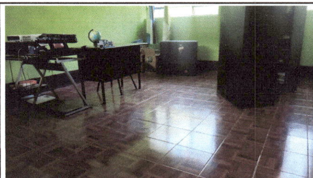
Foto 4: piso cerámico instalado en la dirección del módulo 1.
