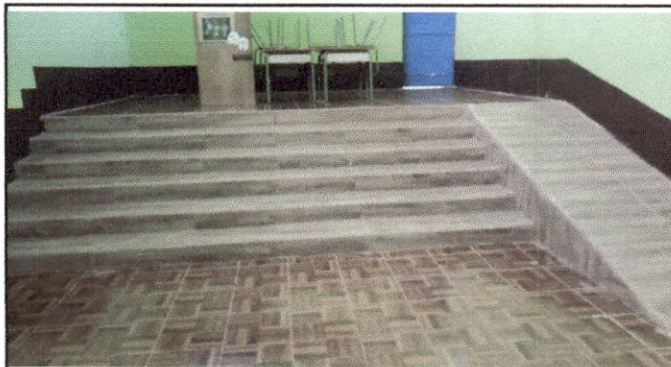
Foto 10: piso cerámico instaldo en las gradas y el escenario del salón de usos múltiples del módulo 1.
