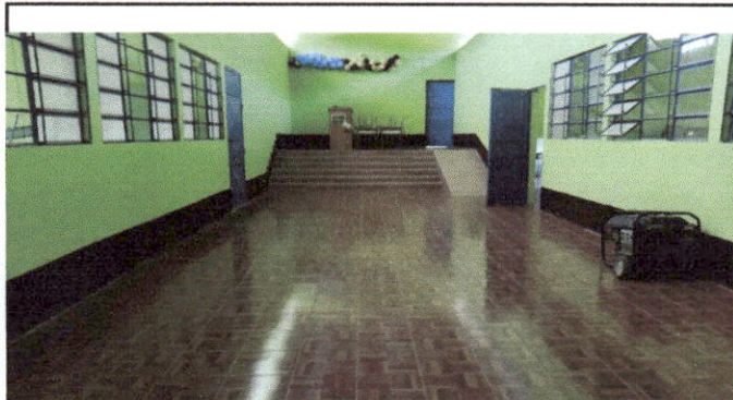
Foto 9: piso cerámico instaldo del salón de usos múltiples del módulo 1.
