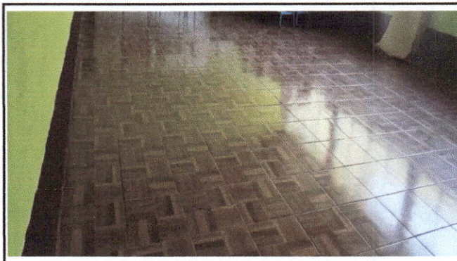
Foto 2: piso cerámico instalado en el aula No.2 del módulo 1.
