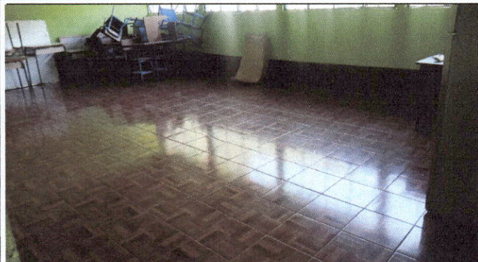
Foto1: piso cerámico instalado en el aula No.1 del Módulo 1.
