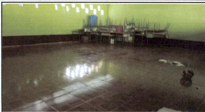
Foto7: piso ceramico instalado en el aula No.2 del módulo. 2 .
