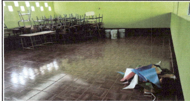
Foto 6: piso cerámico instalado en el aula No.1 del módulo 2
